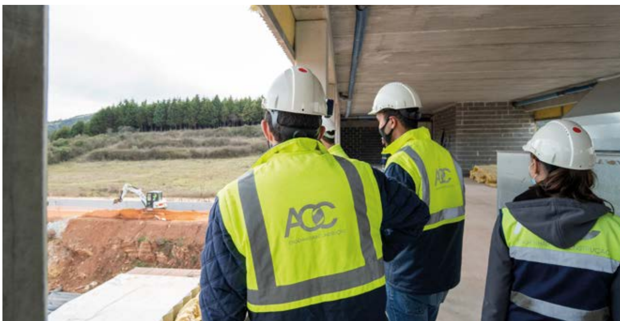
Visita a obra - Hoshi
