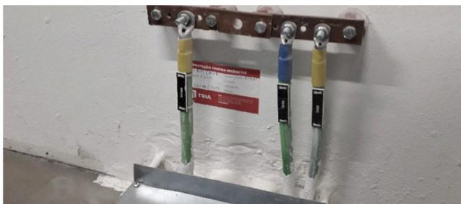
SELAGEM EM ATRAVESSAMENTO DE CABLAGEM ELÉTRICA
